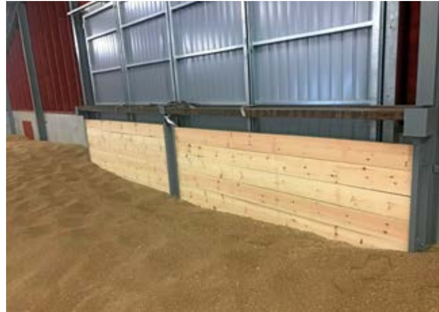
Byggnaden har vikport från EAB, Smålandsstenar på båda kortsidorna. En barrikaderas med travat lösvirke vid lagring av spannmål.
