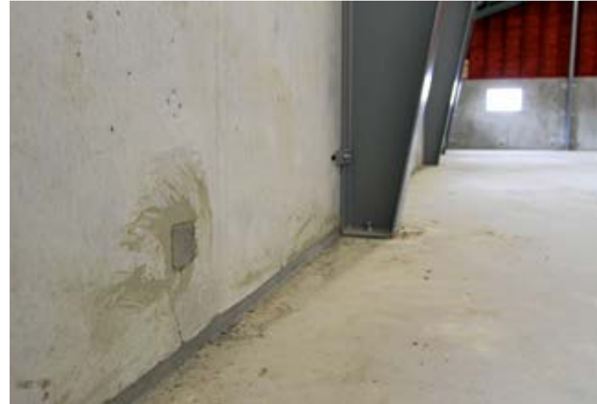
Väggelementen är förankrade med så kallade ankor, ett hål som går snett ner i golvet och som sedan försluts.
